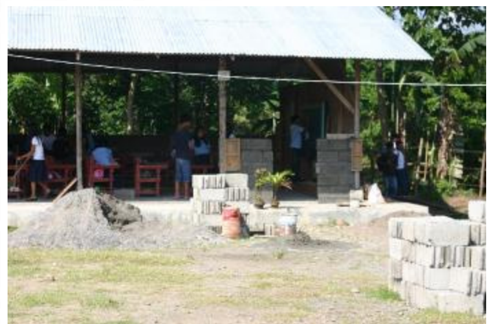
1번 교실벽 공사
